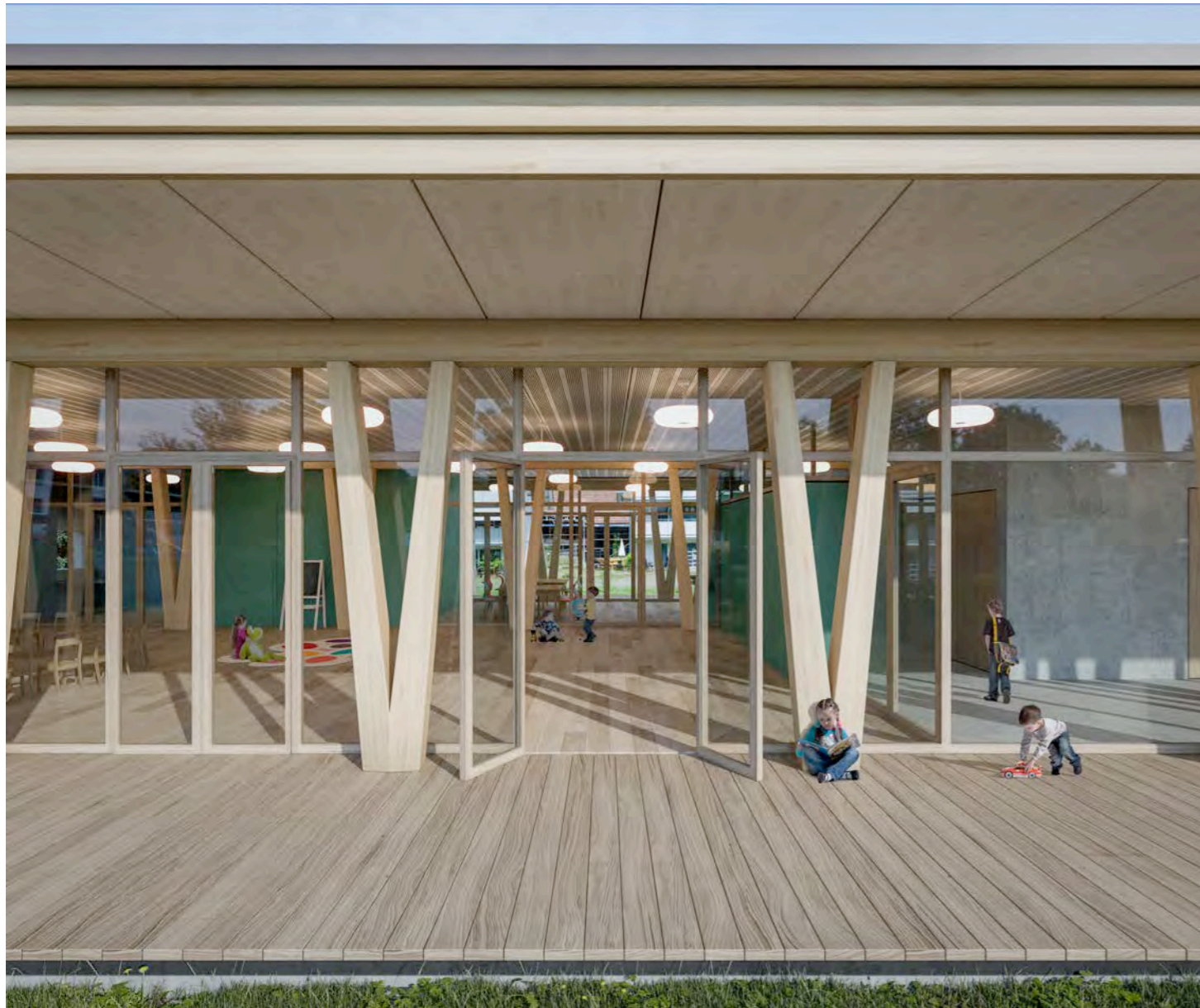
Detailansicht Südwestfassade / Spiellaube
