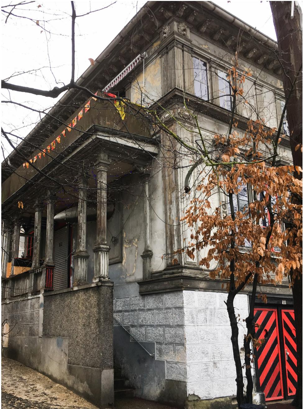
Bild vor der Sanierung, 2019.
