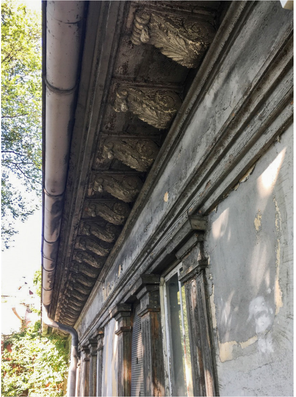
Untersicht mit Fassadenteil.
