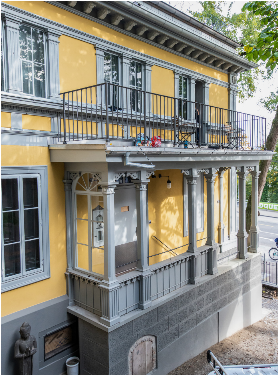
Instandsetzung der Laube. Neuaufbau des Balkons.
