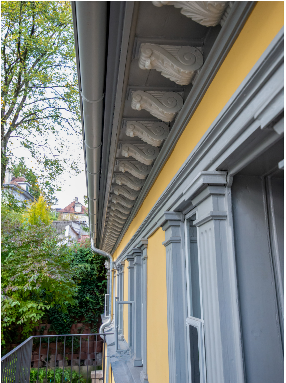
Untersicht, Pilaster und Fentereinfassungen wurden mit Ölfarbe gestrichen.
