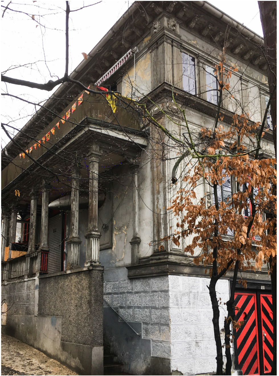
Fassadenteil strassenseitig mit Treppenaufgang zum Obergeschoss.
