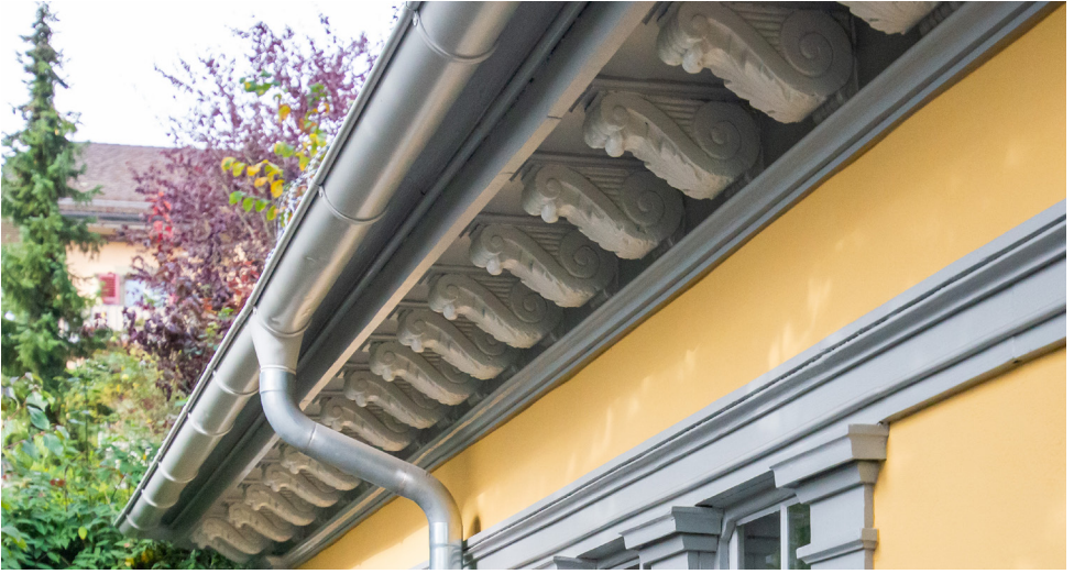
Konsolen in Ölfarbe ausgefasst.
