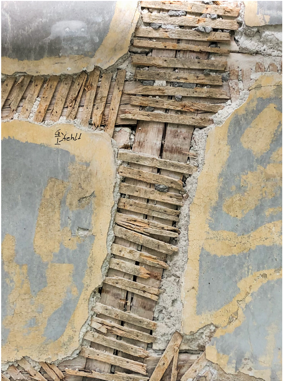
Freigelegtes Riegwerk und Putzfelder, vermutlich mit bauzeitlichem Ockerfarbton der Fassade.
