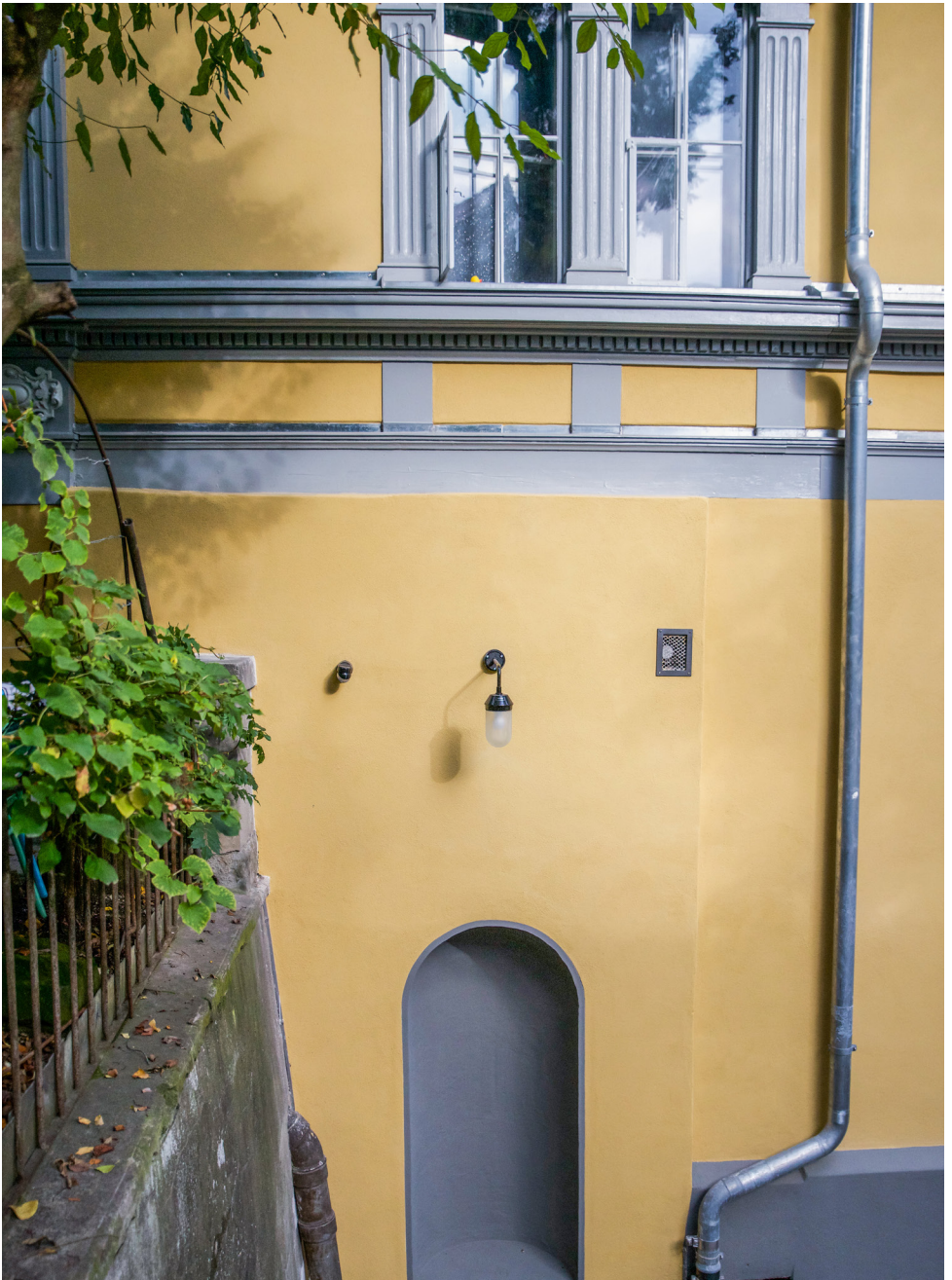
Neuaufbau des Putzes mit Kalkputz. Ergänzung diverser Holzelemente.
