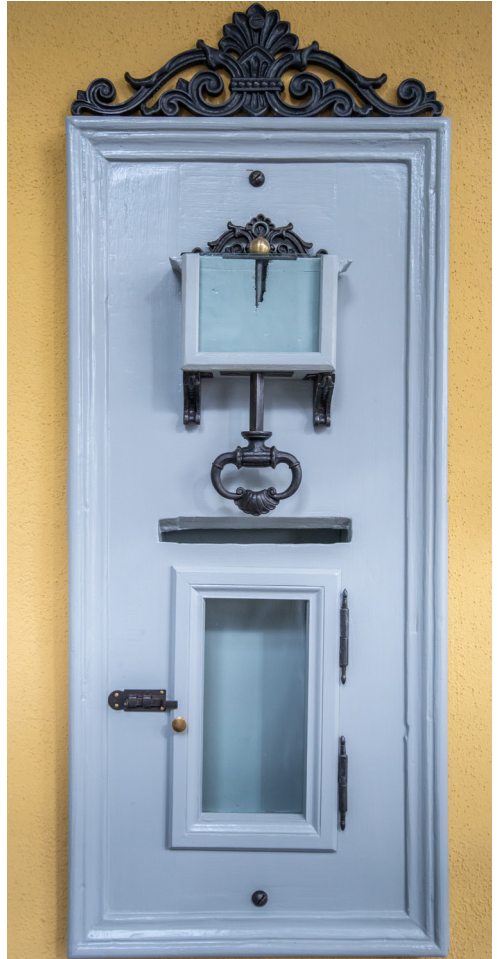
Briefkasten mit Ölfarbe gestrichen. Metallteile mit Leinöl geschwärzt.
