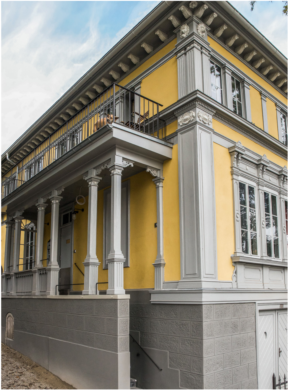
Neuaufbau der Putzfelder mit einem Kalkputz. Gestrichen mit Silikatfarbe. Der Farbton ist eine Anlehnung an das Original. (Handausmischung) Sockelverlauf wieder hergestellt.
